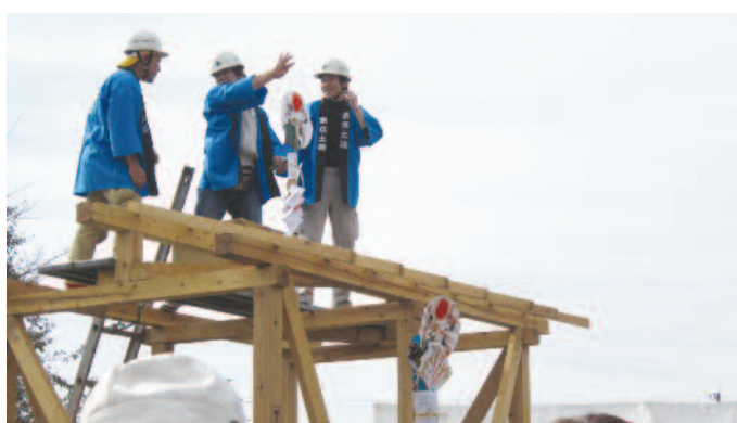
ミニ上棟式で東京土建をアピール
