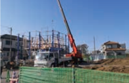
今回訪問に協力いただいた新築工事現場
