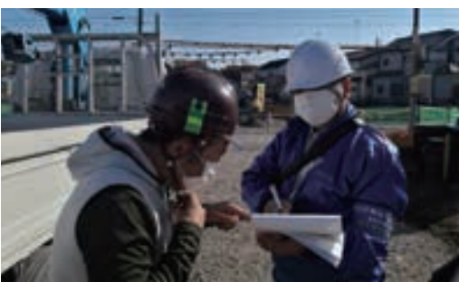
現場のチェックを行い、安全指導する関副部長(写真右)
