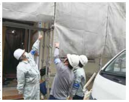
前川委員長(左)、笹原部長(中)も現場を確認してくれました。
